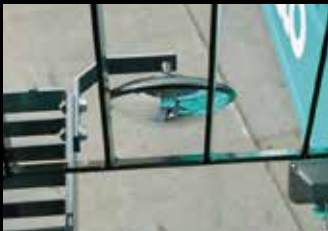
キャブ下視認ミラー エレベータ上昇時にキャブ下の状況を一目で確認可能。
